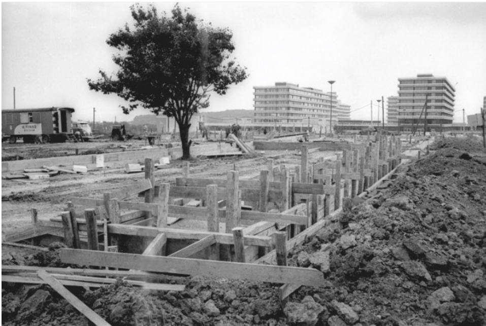
Construction site, Ruhr-Universität Bochum, 1969
